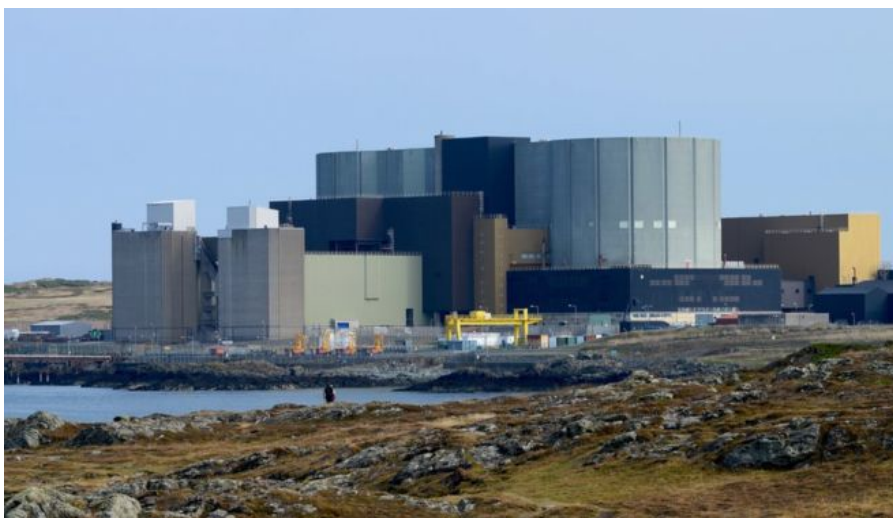
Saluons enfin le dernier réacteur Magnox qui a été arrêté définitivement sur le site de Wylfa, après 44 ans de service.
