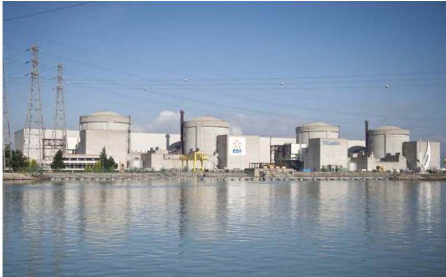
Centrale du Tricastin
