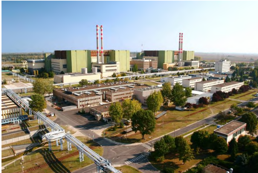
Centrale de Paks (Hongrie)
