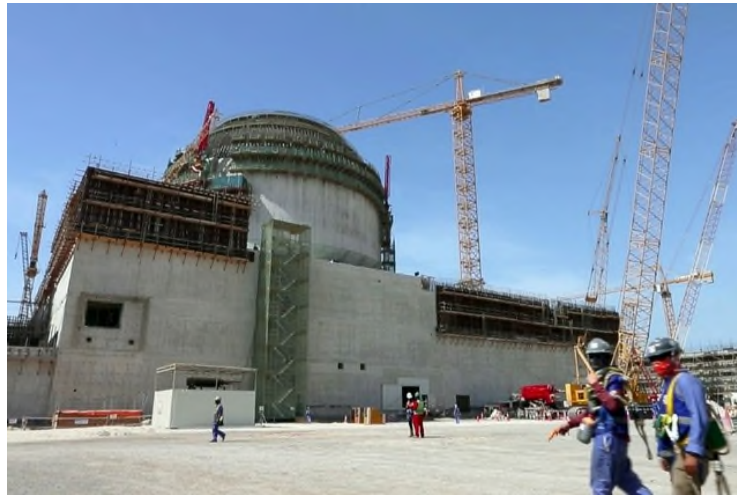
Le chantier de Barakah
