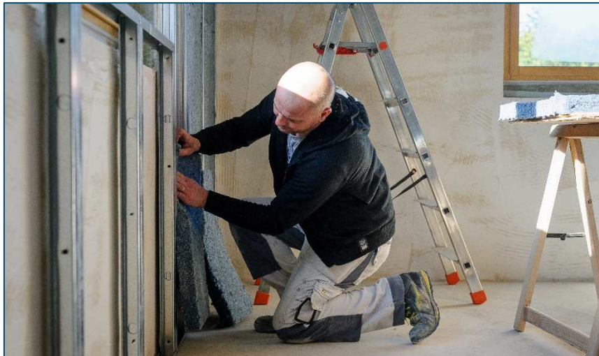
Chantier de rénovation thermique - © Arnaud Bouissou - Terra
