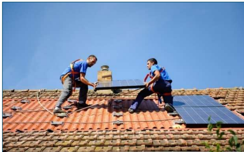
Pose de panneaux photovoltaïques sur une maison individuelle - © Arnaud Bouissou - Terra
