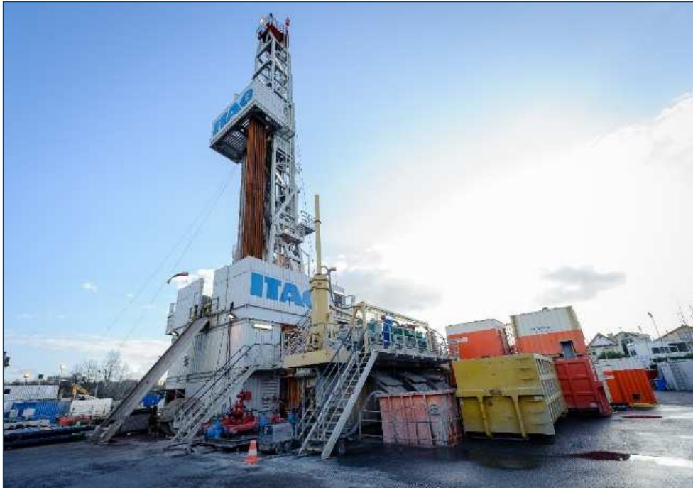
Forage géothermique à Gentilly en Île-de-France - © Arnaud Bouissou – Terra
