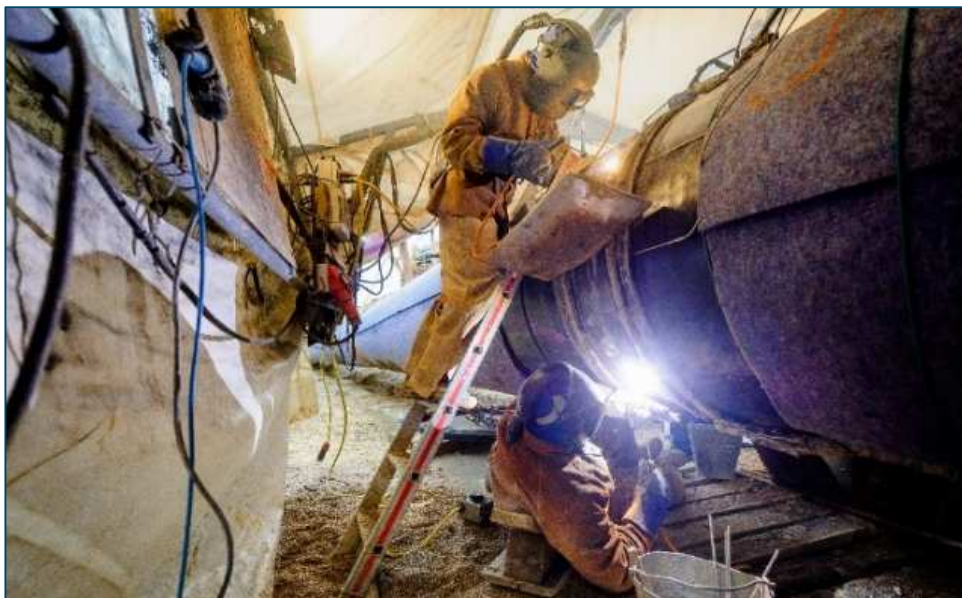
Soudeur sur le chantier de raccordement GRTgaz Val de Saône - © Arnaud Bouissou - Terra
