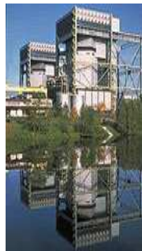
Site en démantèlement
